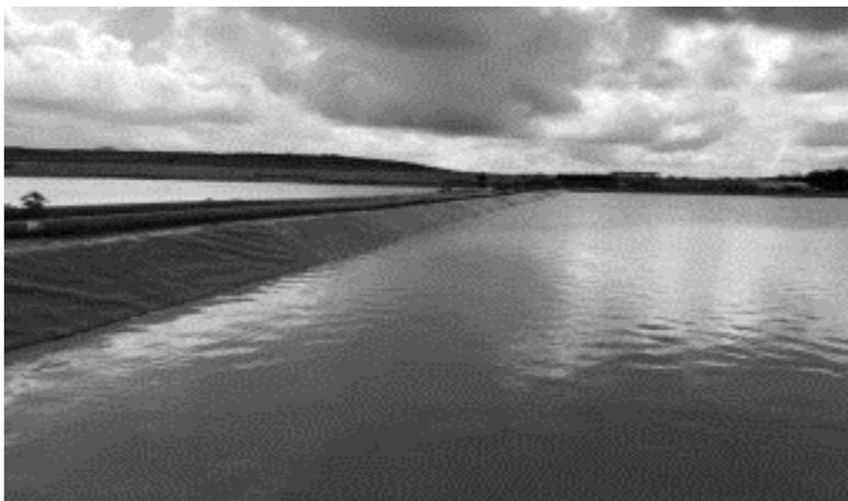
Figura 5 - Bacia de rejeitos (Depósitos de Resíduos Sólidos - DRS 1) com capacidade máxima atingida.
