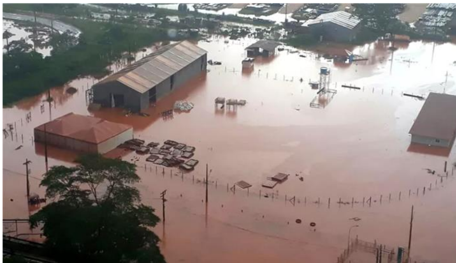
Figura 3 - Acidente da empresa HYDRO no ano de 2018.
