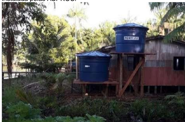
Figura 10. Sistema de aproveitamento de água de chuva instalada pelas ASPROC.
