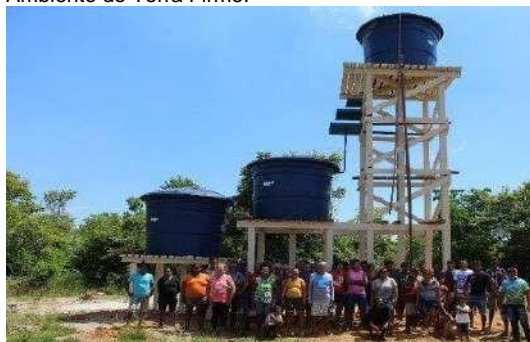
Figura 8. Sistema Pluvial Multiuso Comunitário para Ambiente de Terra Firme.
