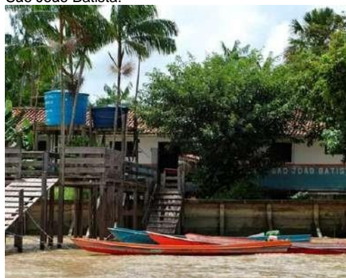
Figura 11. Cisterna Escolar instalada na escola São João Batista.
