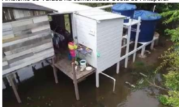
Figura 9. Sistema Pluvial Multiuso Autônomo para Ambiente de Várzea na comunidade Costa do Aritapera.
